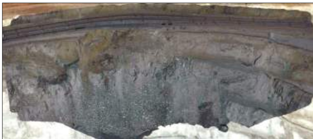
Рис. 3. Трехмерная модель северного участка зоны обрушения
